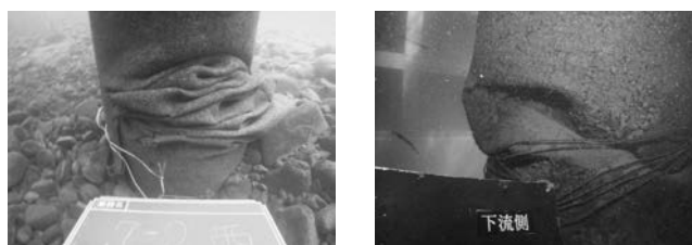
写真－3 全ての橋脚を調査
