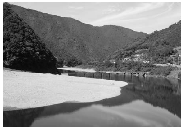
写真-1 岩間大橋(岩間沈下橋)全景
