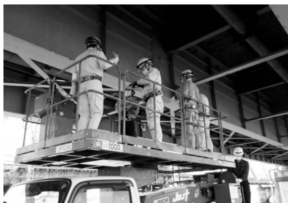
写真-3 現地実習の様子
