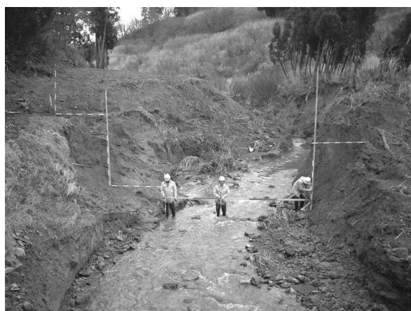
写真—5 被災した護岸の測量
