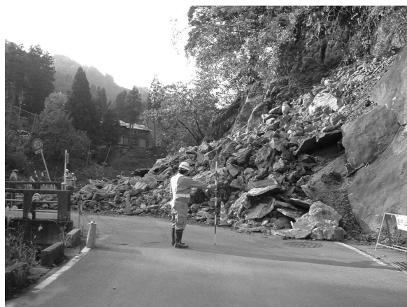
写真－1 崩落により道路不通
