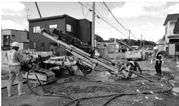
写真-1 宅地部の地盤改良の様子（道路からの斜め削孔）
