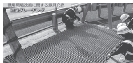
写真－4 軽量グレーチングの採用
