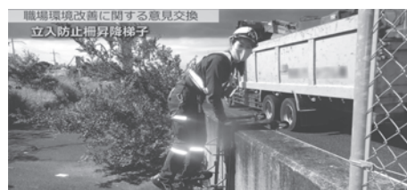
写真－5 立入防止柵昇降梯子の製作
