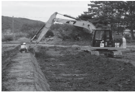
法面・水平面整形作業
