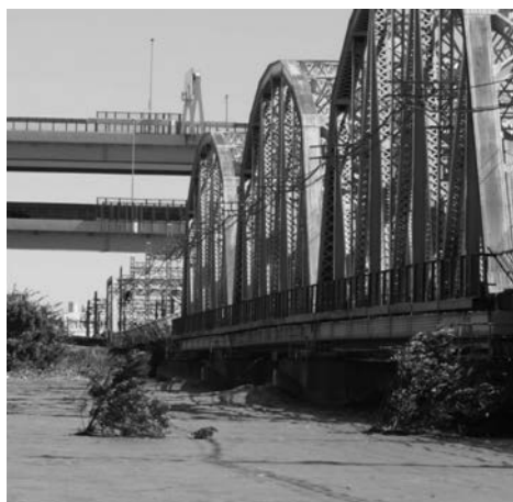
写真-1 京成本線荒川橋梁の令和元年東日本台風時の状況（桁下約 120 cm まで水位が到達）
