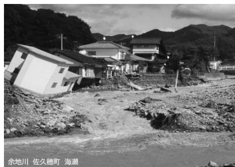
写真－1 被災状況（余地川）
