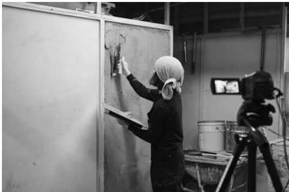
写真-4 モデリング訓練 訓練生の塗る姿をビデオで撮っておく
