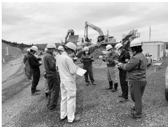
写真－1 受発注者による安全パトロール
