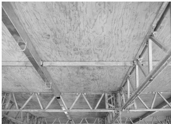
写真-2 クイックデッキ・床組み構造
