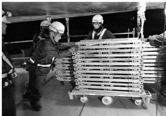
写真－7 クイックデッキ台車使用状況
