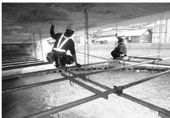
写真-5 在来の吊足場の架設状況
