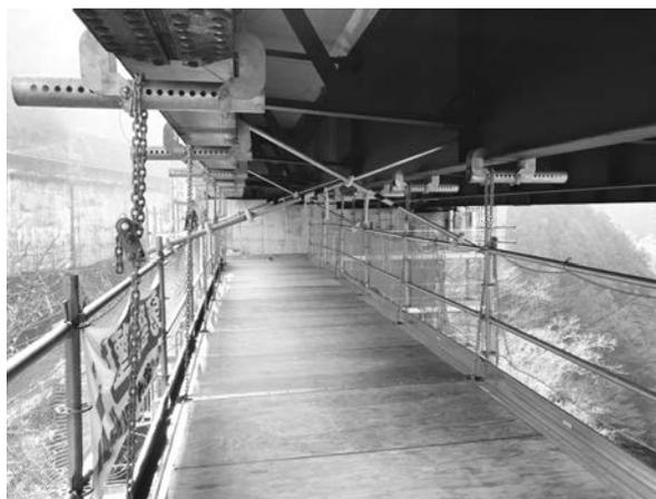
写真-14 クイックデッキによる搬入路
