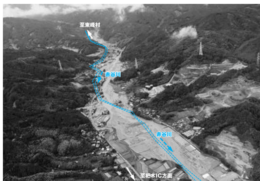
写真－４ 甚大な被害が発生した赤谷川（朝倉市 杷木星丸）【国土地理院提供】
