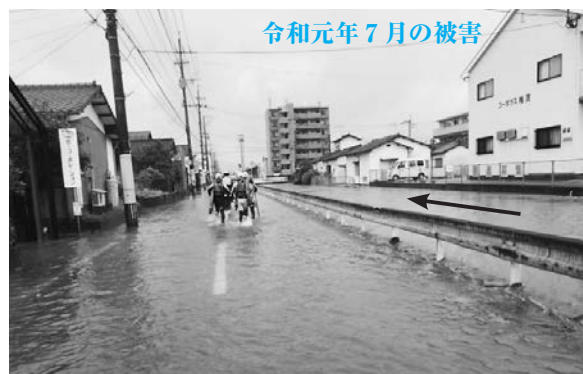
写真－1 4 年連続 5 回の浸水被害を受けた池町川(久留米市)
