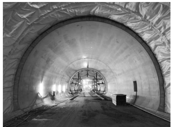
写真-3 覆工コンクリート全景
