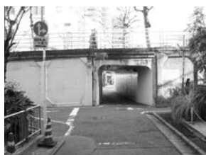
側道状況（明治通り側）
