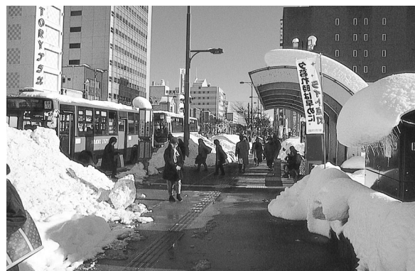
写真ー４② 融雪幅を広げて、使いやすくなった市役所前のバス停
