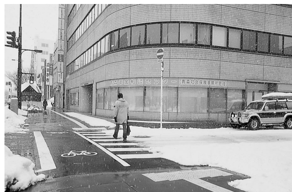
写真ー５② 狭い市道部分も連続して融雪されている
