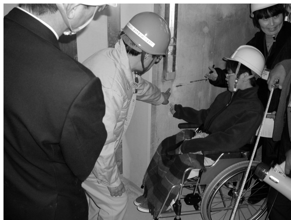
写真-5 エレベーターホールでの検証状況
