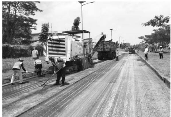
写真－5 試験施工①切削
