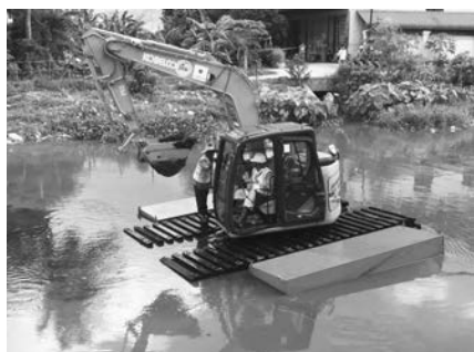
写真－7 水陸両用掘削機による浚渫工事
