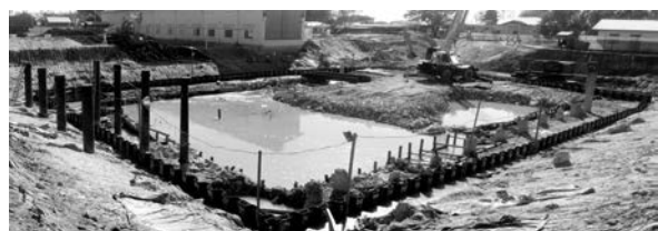
写真－3 ミャンマー：ニャウフナッピン浄水場基礎工事
