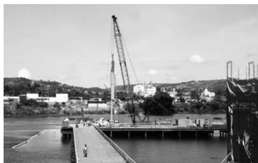
写真－4 ウガンダ：ナイル川斜張橋基礎工事
