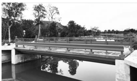
写真－8 ベトナム：めがね橋架設
