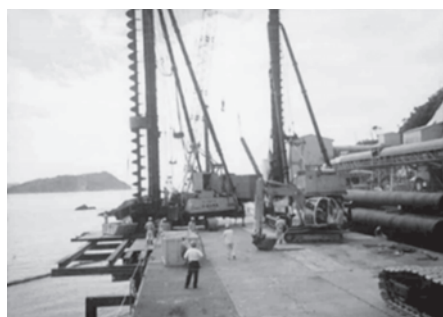
写真－1 硬質地盤岩盤杭打機の開発
