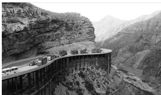
写真-5 パキスタン国道70号線改修工事 SQCピア工法本橋区間
