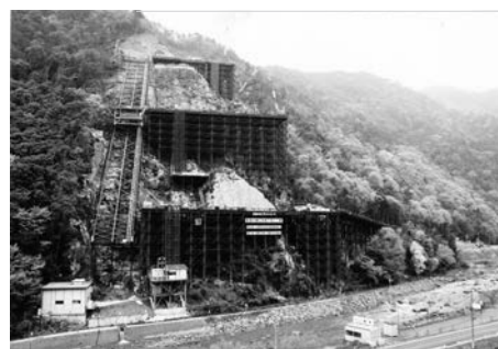
写真－2 SqC ピア工法（上部パネル先行架設工法） ／広島空港大橋
