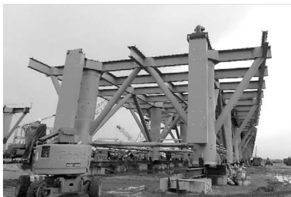
写真-1 ティラワ港開発事業施工時の状況（左：ジャケッ部材，右：ジャケッ据付けの様子） （出典：日本工営株式会社）
