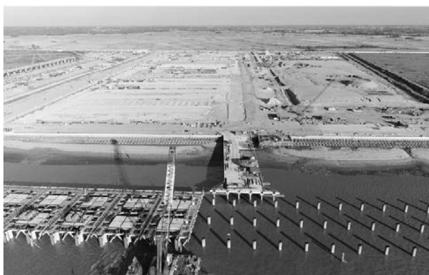
写真-1 ティラワ港開発事業施工時の状況（左：ジャケッ部材，右：ジャケッ据付けの様子） （出典：日本工営株式会社）
