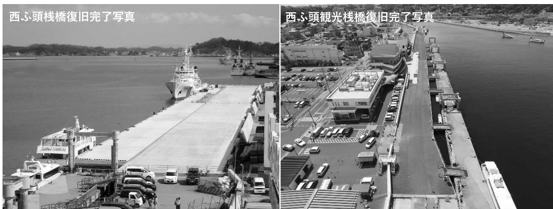
写真-1 施設復旧完了
