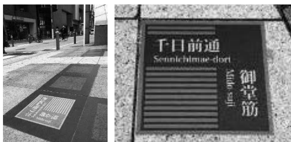
写真-7 仮設置したサイン（モックアップ）
