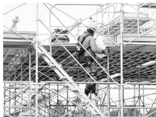
写真-3 現場内小運搬
