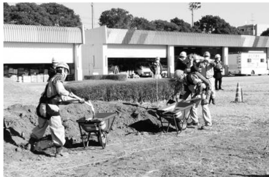
写真-2 人力土工作業
