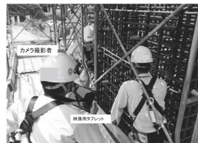
写真-3 現場の状況
