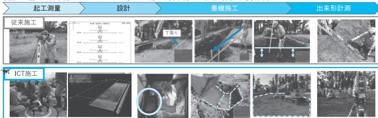
図-2 ICT 施工と従来施工の比較
