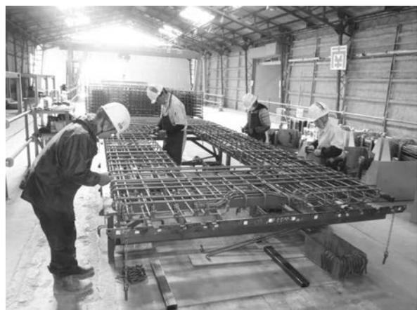
写真-3 従来の手作業による鉄筋組立
