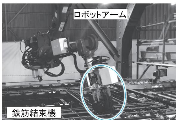
写真－5 三田川 PC 工場での鉄筋結束状況
