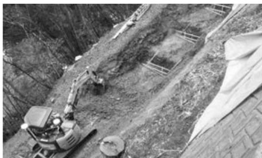
写真-3 ICT 建機による掘削作業
