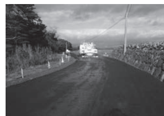
ディストリビュータ 施工状況
