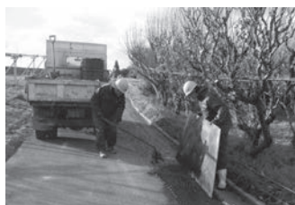
アスファルトエンジンブレイヤ 施工状況
