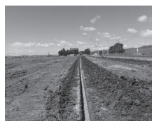
被覆材施工完了
