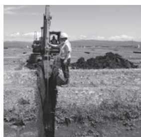
トレンチャ掘削
