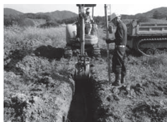
バックホウ掘削
