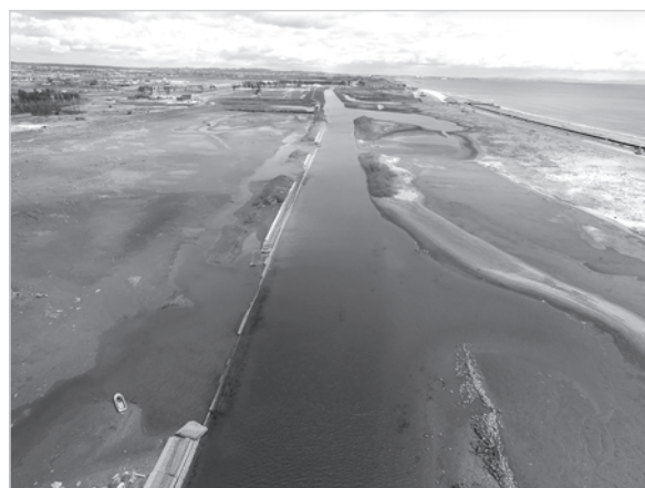
写真－2 県道仙台亘理自転車道線 ①整備前(震災直後)
