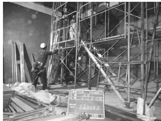
写真－2 足場組立状況
