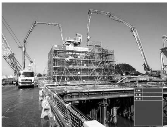
写真-5 中埋コンクリート打設状況
