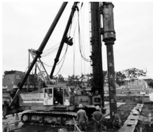
写真-3 鋼管杭施工状況（全景）
