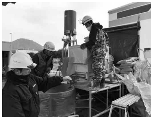
写真-7 グラウト注入状況
