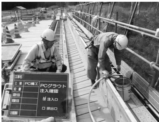
写真－8 グラウト注入状況
