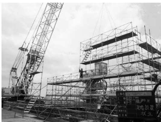
写真-6 足場設置状況
