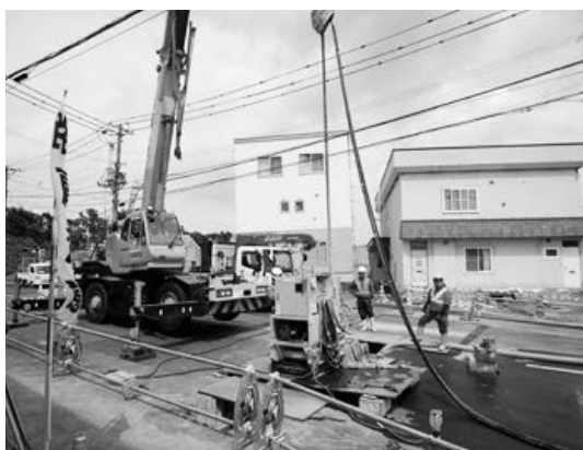
写真-1 二重管工法施工状況（全景）
