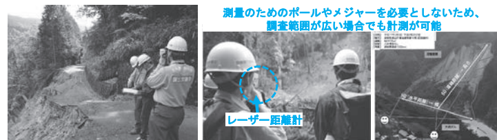
立ち入り困難箇所におけるレーザー距離計の活用事例
