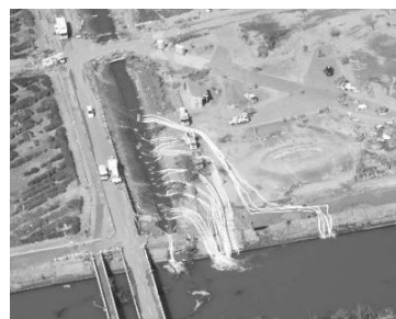
写真－4 排水ポンプ車の集中投入
