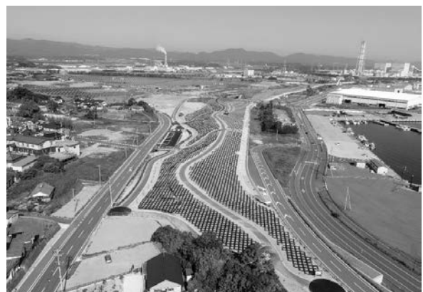
写真-4 原釜尾浜防災緑地（相馬市）
