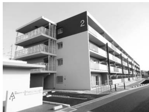
写真－2 災害公営住宅南青山アパート
