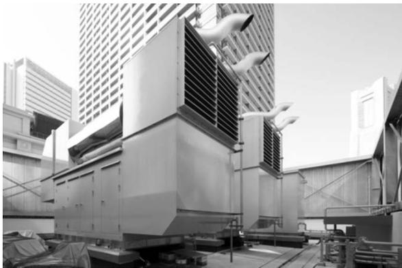
写真-11 塀の内側に設置された非常用発電設備
