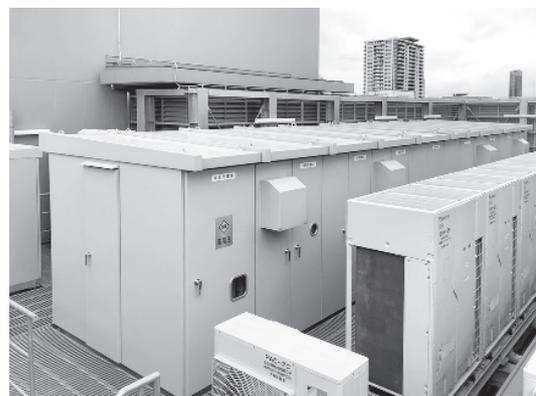
写真-6 屋上の高圧受変電設備
