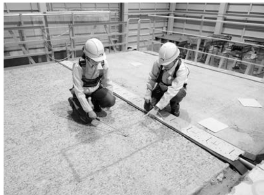
写真－11 撤去床版
