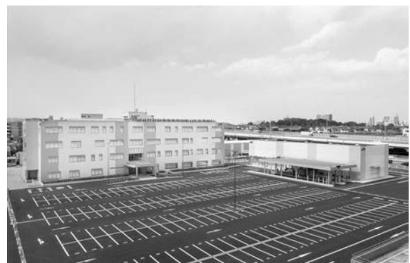
写真-1 社屋棟（左）と開発・実習棟（右）
