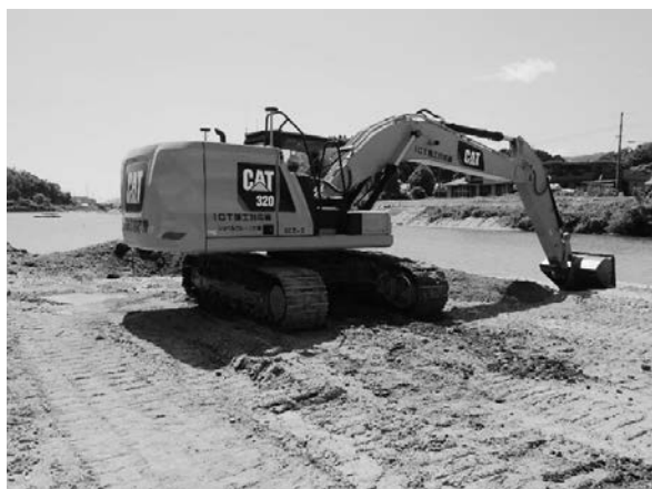
写真－４ ICT 建機による水中掘削
