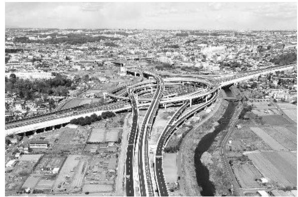
写真-2 完成した横浜北西線の横浜青葉JCT 資料：首都高速道路株式会社
