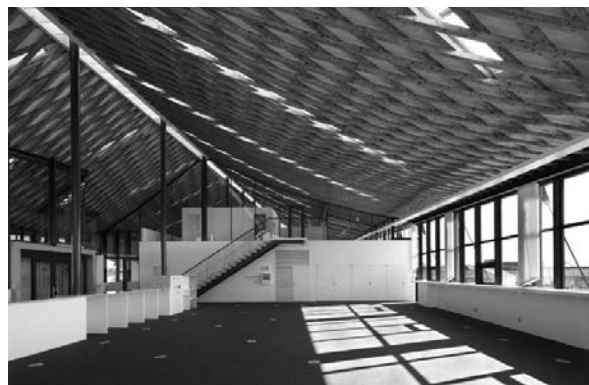
写真－7 格子膜構造による材の軽量化 （群馬県農業技術センター（本館・会議棟））
