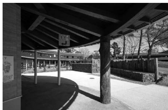
写真－6 深い軒の出・露出しない接合金物 (仙台市八木山動物公園 ふれあい館・ グーゲーテラス)
