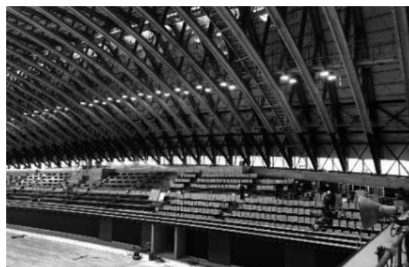
写真－5 地域産材の強度分布を踏まえた架構 (大分県立武道スポーツセンター)
