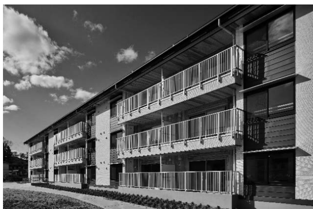
写真－1 CLTパネル工法による公営住宅 (福島県復興公営住宅 磐崎団地)
