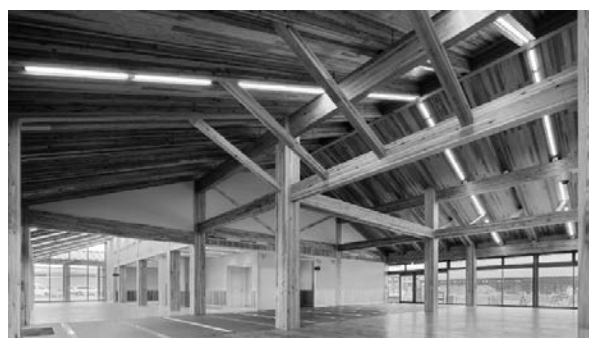
写真－4 燃えしろ設計の木造準耐火建築物 (平城宮跡歴史公園朱雀大路西側地区 観光案内・物販棟)
