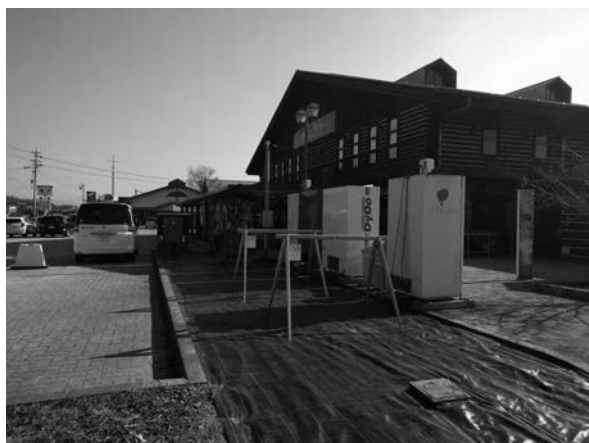
写真－４ 道の駅でのサイクルラック設置状況
