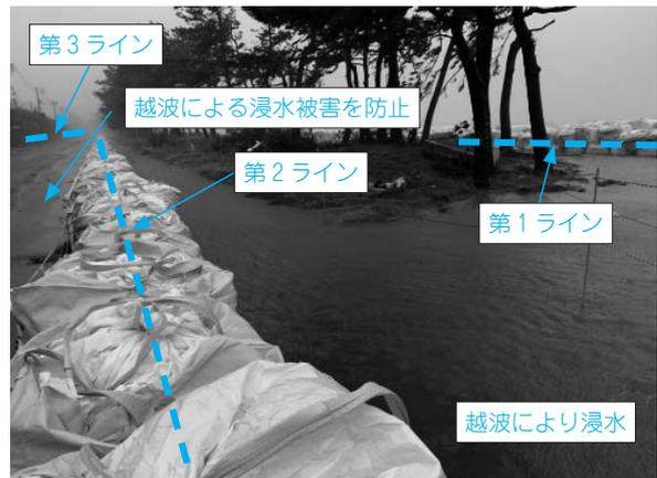
写真－3 土嚢を3列に配置し浸水被害を防止
