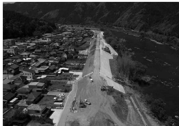
写真-2 那賀川における堤防整備
