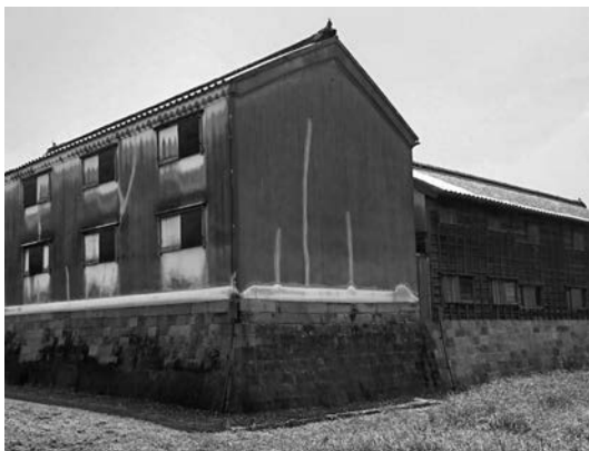
写真-1 洪水による流出を防ぐため、石垣により嵩上げを行っている家屋
