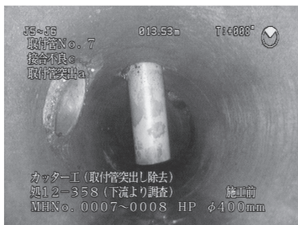
写真ー9 下水管内の障害物
