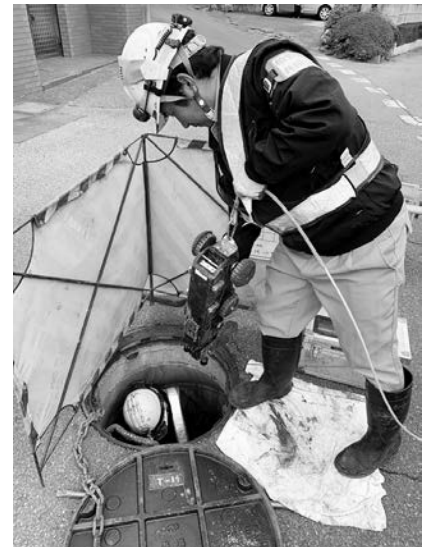
写真－4 自走式簡易カメラ
