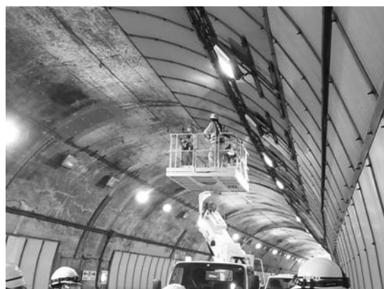
写真－5 国道 41 号 七宗第四トンネル（中部 MC）
