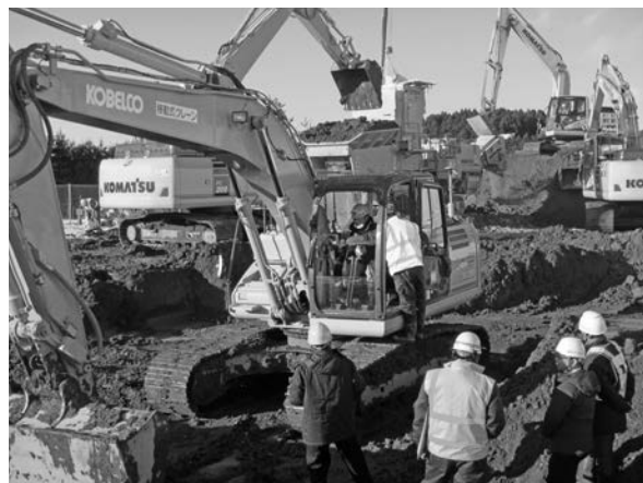
写真－2 ICT 施工技術見学会の様子 八戸環状線（天久岱工区）道路改良工事
