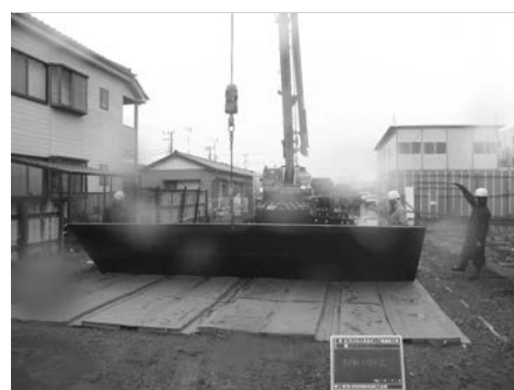
写真－11 防振マットの設置
