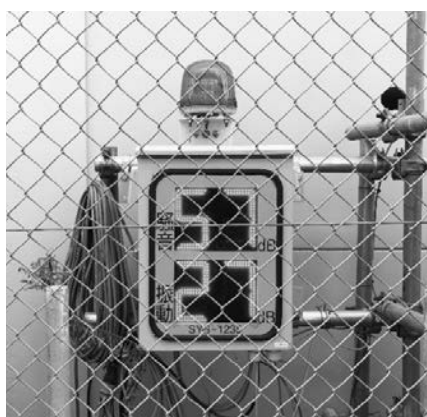
写真－10 振動騒音計の設置
