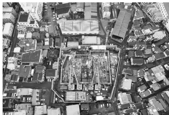
写真－1 住宅が密集している工事場所周辺
