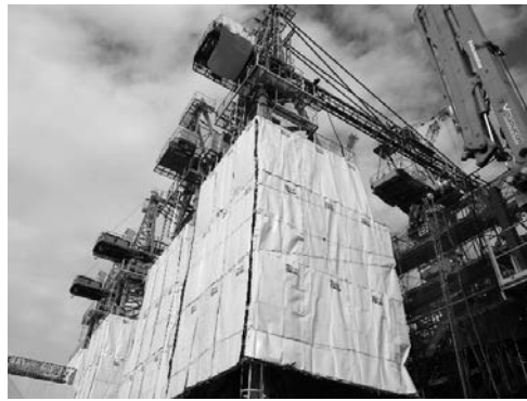
写真-12 ホッパー内ゴム板と外部防音シートによる騒音対策
