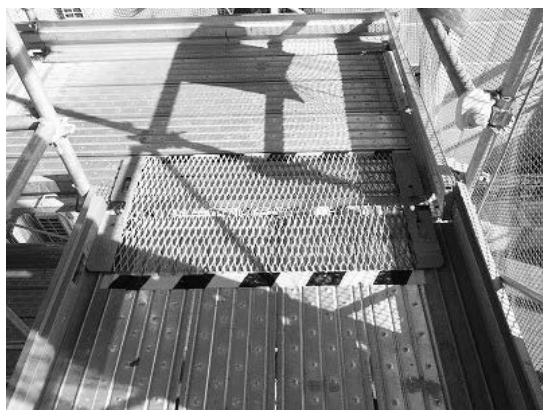
写真－5 通路の養生②
