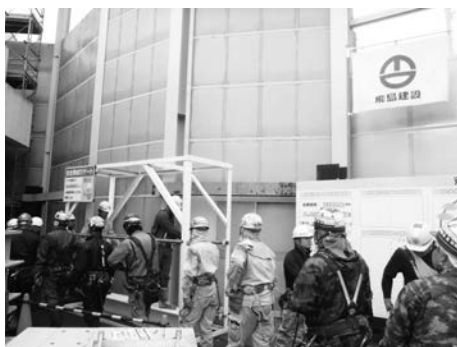
写真－2 安全帯試行ゲート
