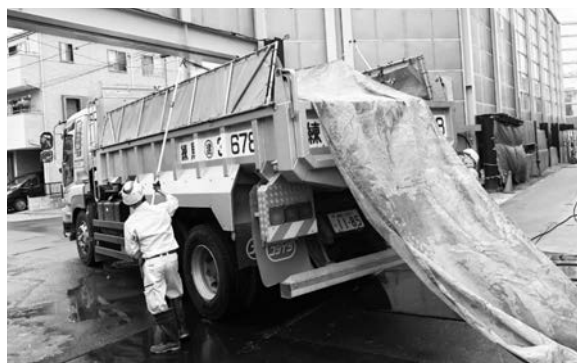
写真－17 荷台シート掛け作業
