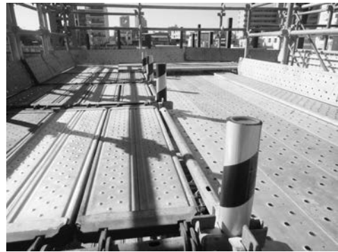
写真－3 クッションシート製カバーの取り付け
