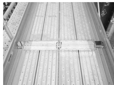
写真－4 通路の養生①
