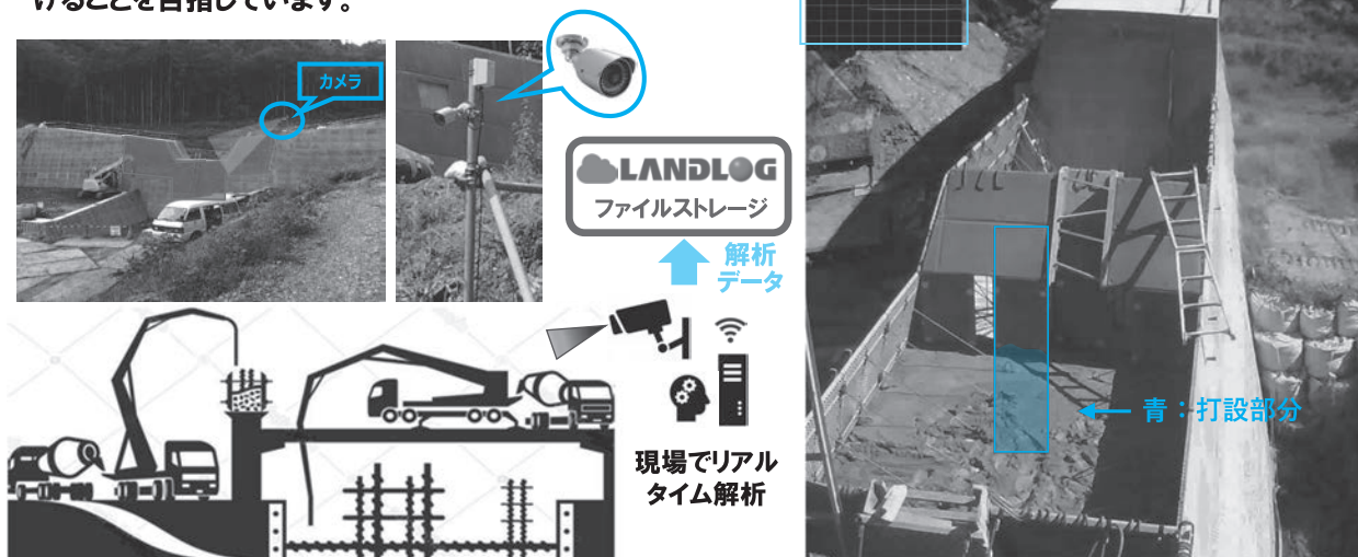
図－５ 画像認識技術を用いた生コン打設状況の把握
