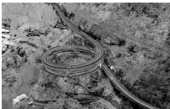
図－5 ハイブリッドデータ (国道 414 号七滝高架橋付近)
