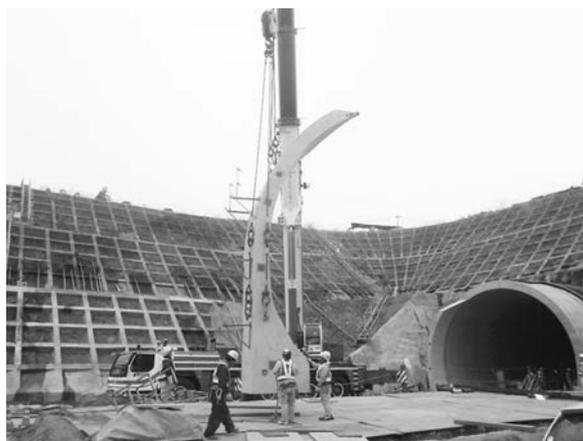
写真-2 側壁部材の設置
