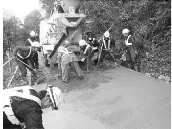
写真-9 コンクリート打込み
