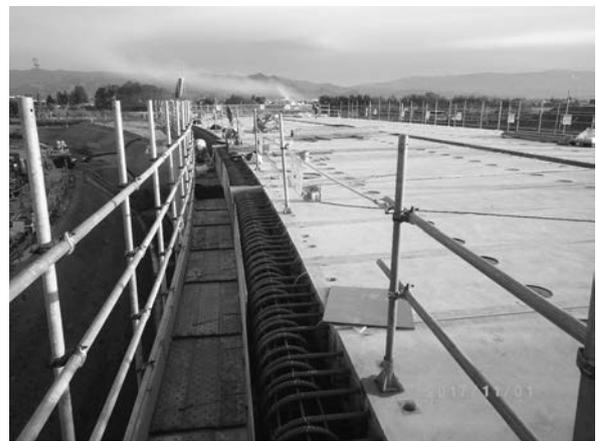
写真-5 ループ継手構造
