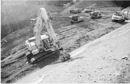
写真-4 法面掘削状況
