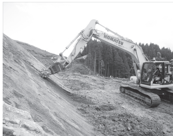
写真－3 法面掘削状況
