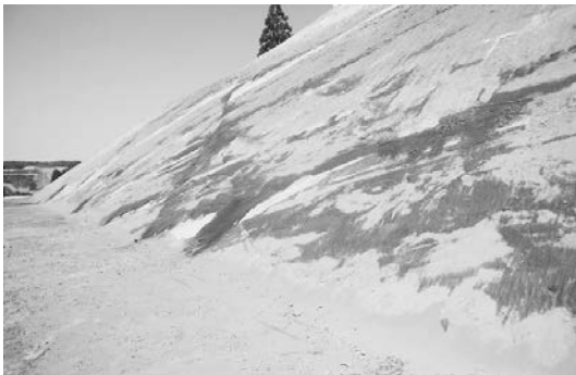
写真-6 法面整形完了
