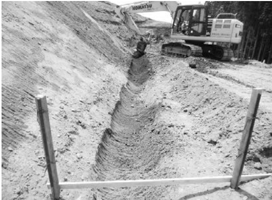
写真-5 水路掘削状況
