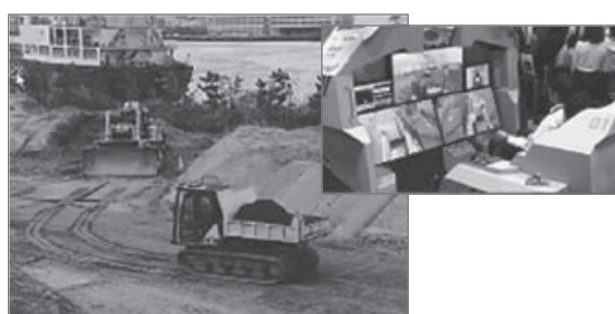
図-6 5G等を活用した無人化施工の現場実証イメージ
